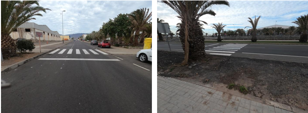
Imagen 02.1 y 02.2. Cruces de calzada a acondicionar en calle Las Adelfas y Canal.
