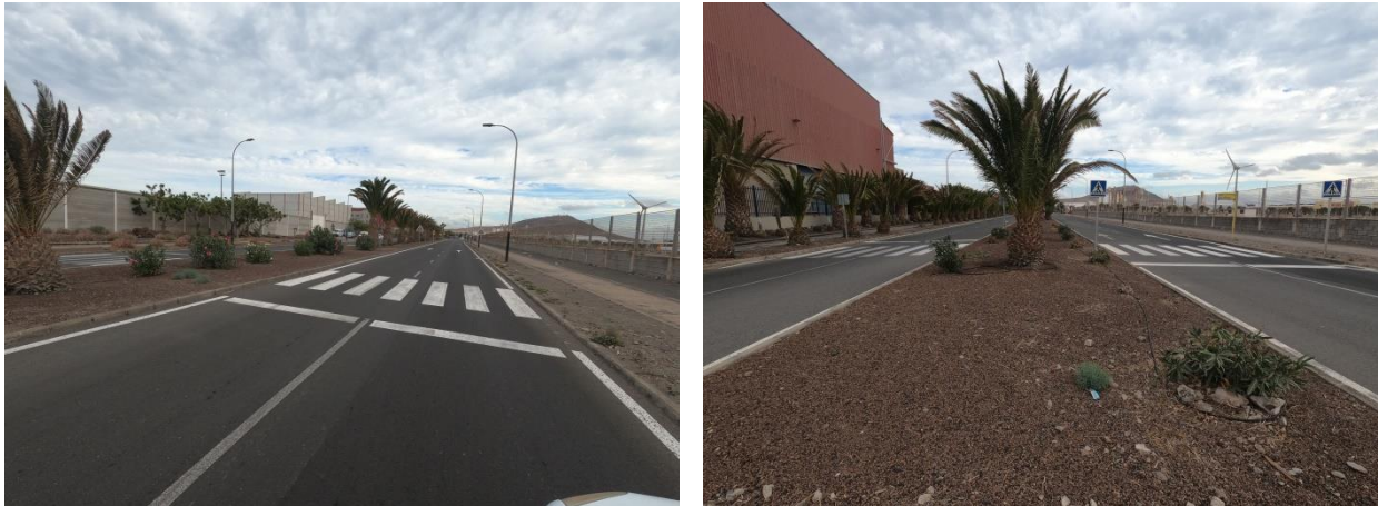
Imagen 04.1 y 04.2. Cruce de calzada con mediana en calle Los Dragos.
