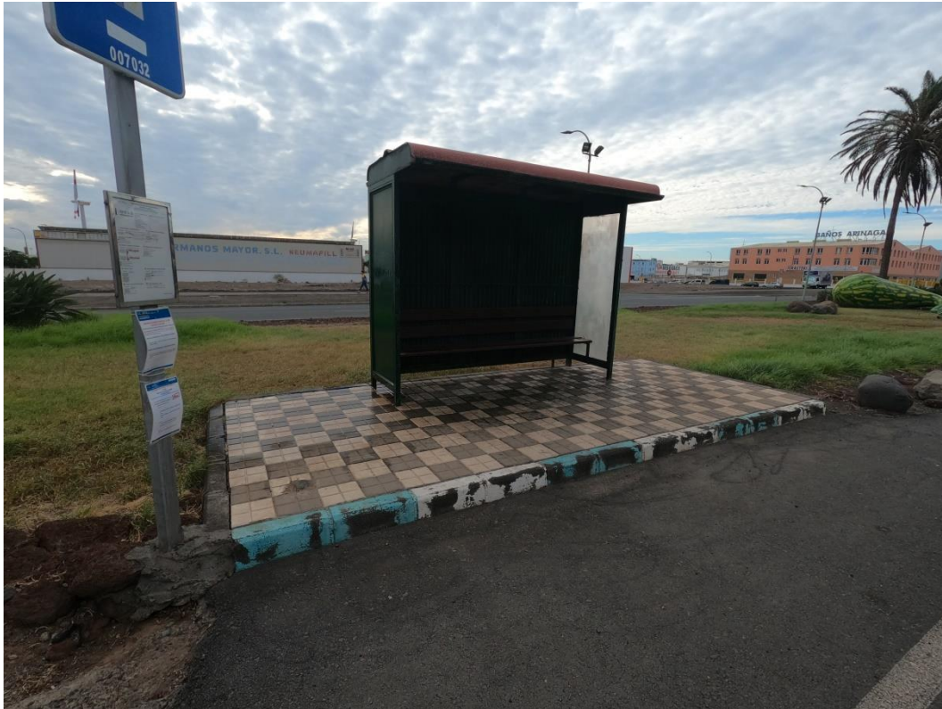
Imagen 08. Parada de guaguas GC-191. Atrás, situación de la nueva pasarela.
